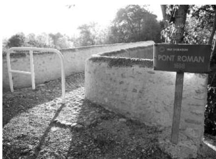
Il a reçu un « lifting », mais le résultat est satisfaisant. Le travail effectué est de qualité, avec des matériaux choisis et une application traditionnelle. Un bémol toutefois, il a fallu installer des barrières de part et d'autre du pont, afin d'éviter une dégradation trop rapide de ce lieu par des utilisateurs peu scrupuleux, motos, quad, etc.
