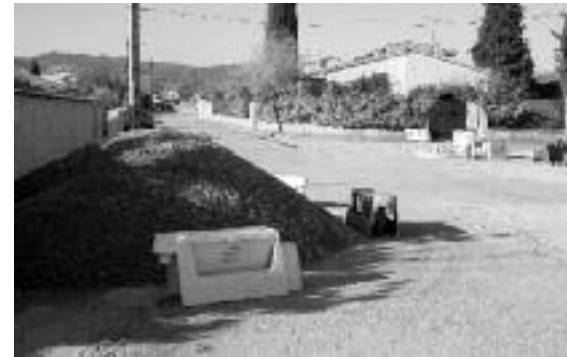
Le chemin des Mélanes en travaux.
