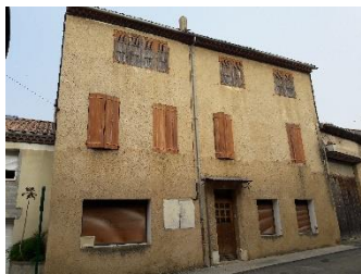
Besoins de travaux moyens
