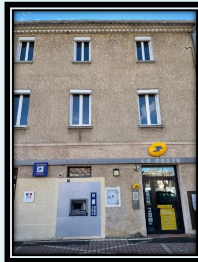
Réhabilitation de 2 appartements
