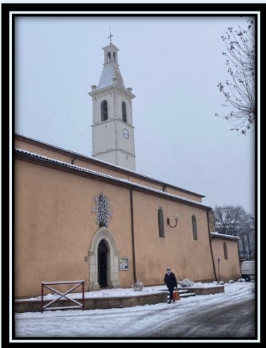
Eglise Façades tranche 3
